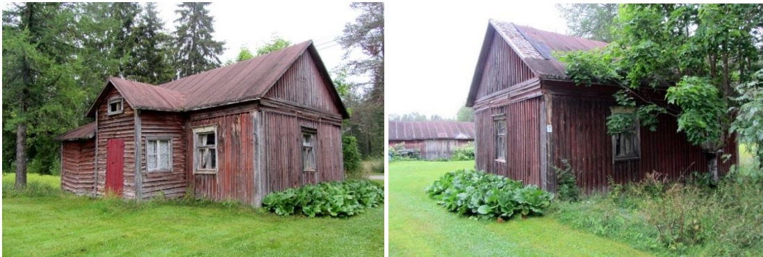
Väilän vanha päärakennus Periojantien varressa (Veera Sanaksenaho 2017)
